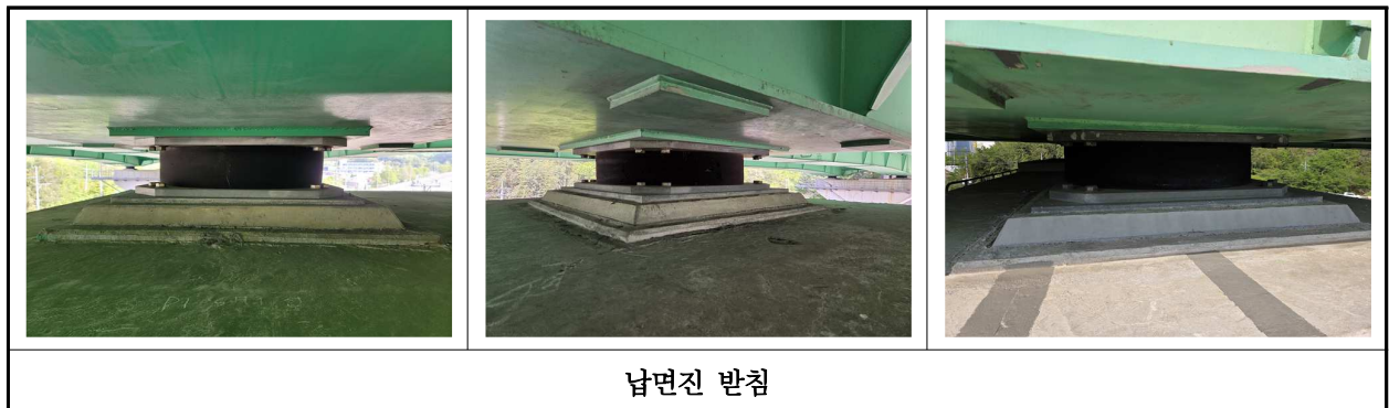
【사진 26.3.13】 교량받침 전경
