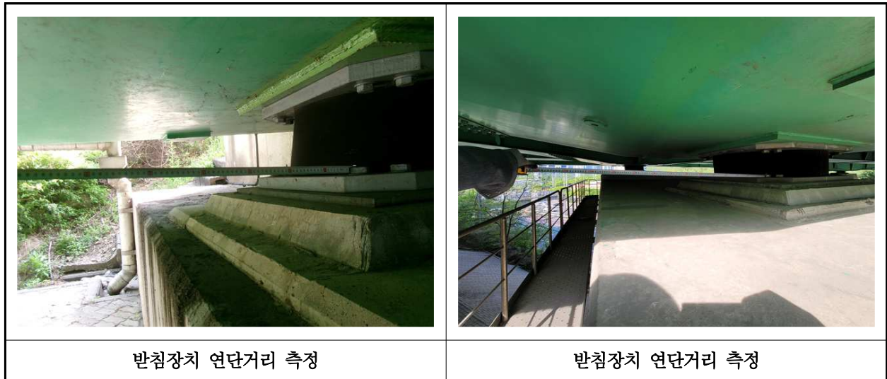
【사진 26.3.15】 교량반침장치 연단거리측정
