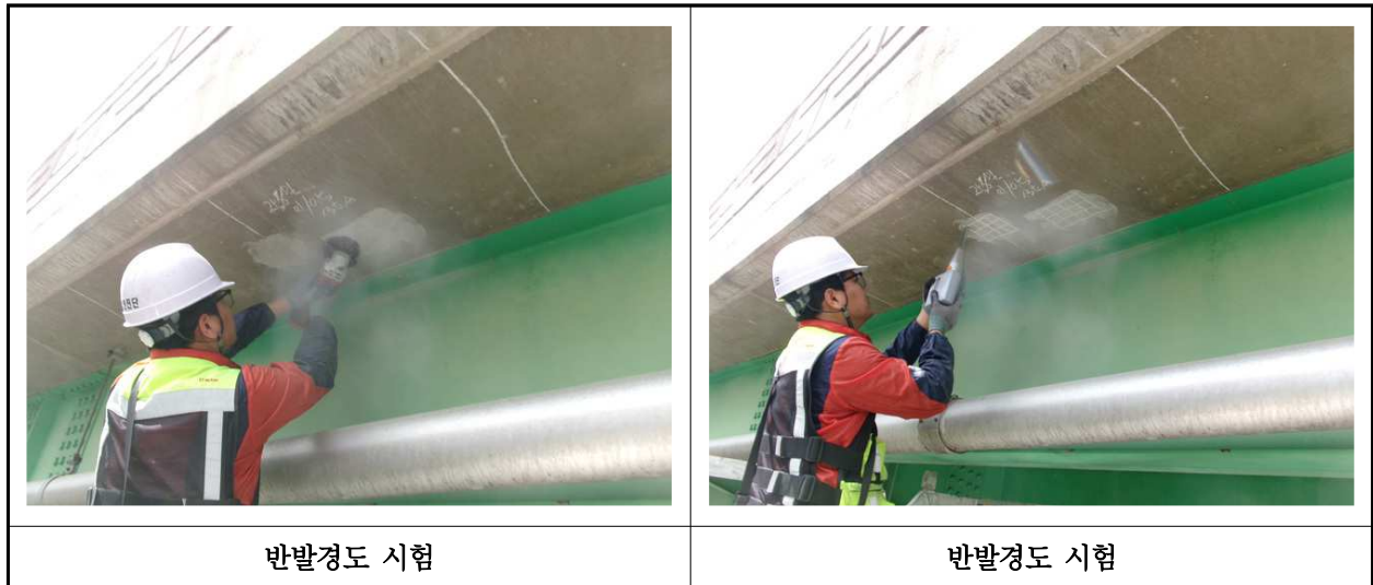
【사진 26.4.2】 반발경도시험 현장사진
