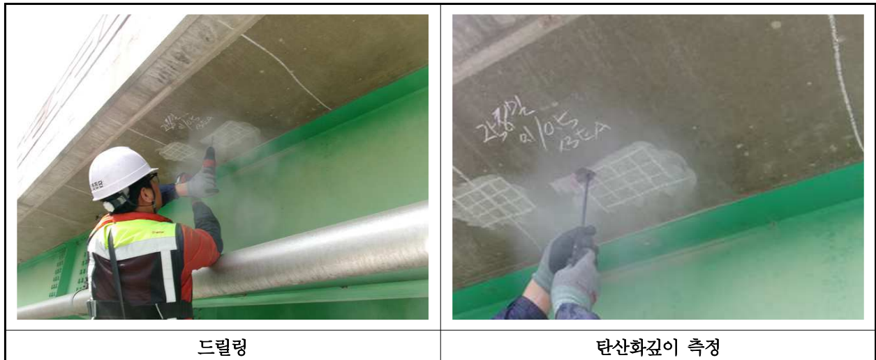
【사진 26.4.3】 탄산화 깊이 측정 현장사진
