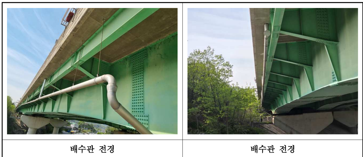
【사진 26.3.22】 배수시설 전경
