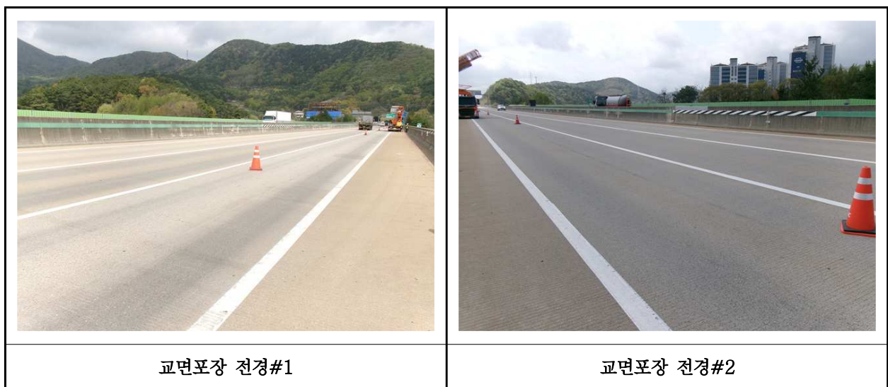
【사진 26.3.20】 교면포장 전경
